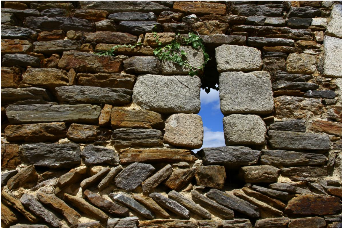
Château d'Hautpoul, détail. Fenêtre et opus spicatum.
