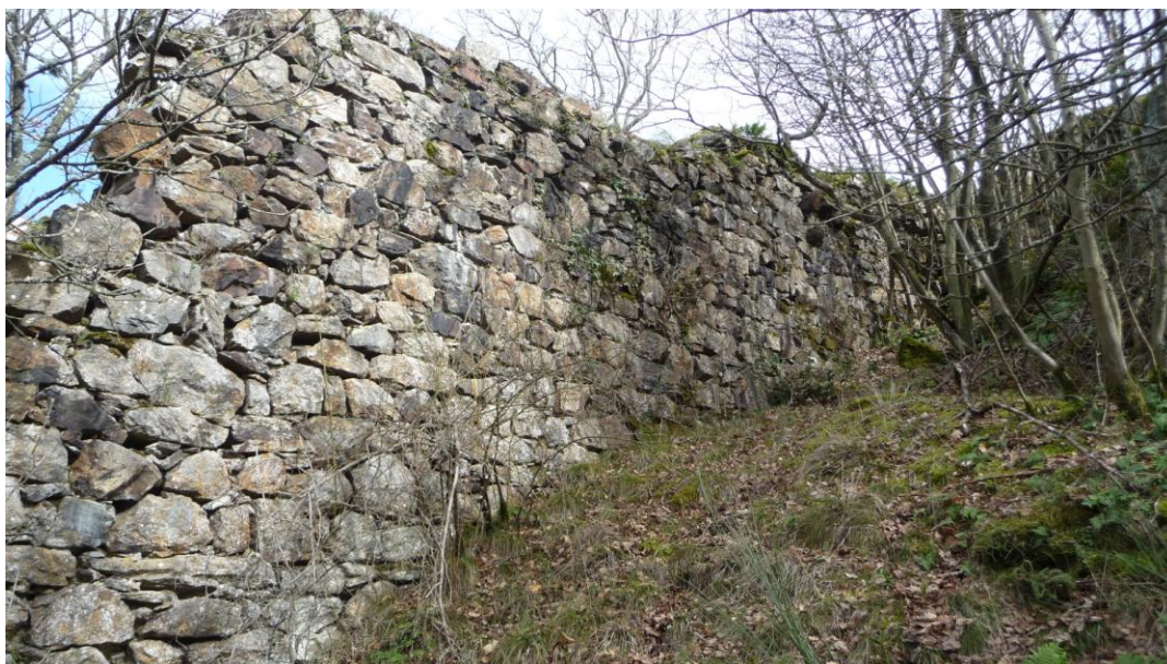
Fig. 4 : Eperon de Saint-Sauveur : le puissant mur de défense oriental (vue intérieure).
